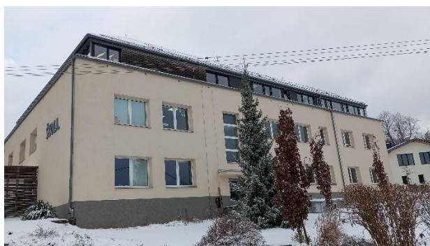
Obr. 23 Základní a mateřská škola
